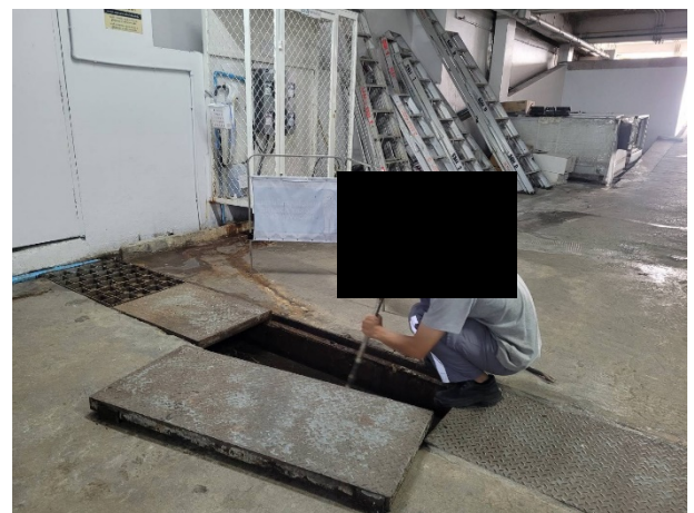
รูปที่ 2.2-31 ขุดลอกท่อระบายน้ำ
