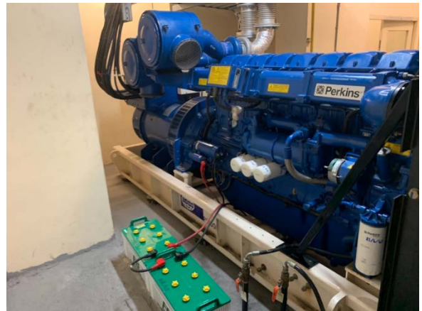
รูปที่ 2.2-29 ห้องเครื่องกำเนิดไฟฟ้าสำรอง
